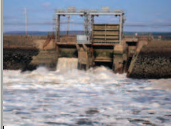
الشكل ١٨ محطة طاقة تعتمد على طاقة المد والجزر في توليد الطاقة الكهربائية.
