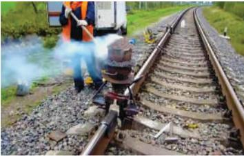
**سؤال** يُستخدم تفاعل التيرمايت في لحام سكك الحديد، حيث يتفاعل أكسيد الحديد (III)  $\text{Fe}_2\text{O}_3$  مع الألمنيوم لإنتاج أكسيد الألمنيوم  $\text{Al}_2\text{O}_3$  والحديد السائل، حسب المعادلة الكيميائية الموزونة الآتية:
