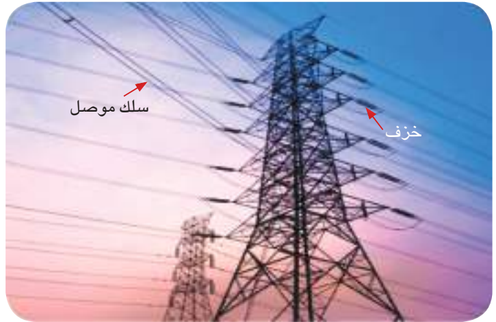
▲ تستخدم الأسلاك النحاسية لتوصيل الكهرباء إلى بيوتنا
