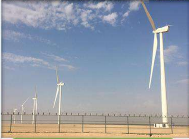
محطة الشقاييا لطاقة الرياح
