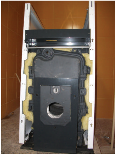
الشكل (10): يوضح طريقة عزل المرجل.
