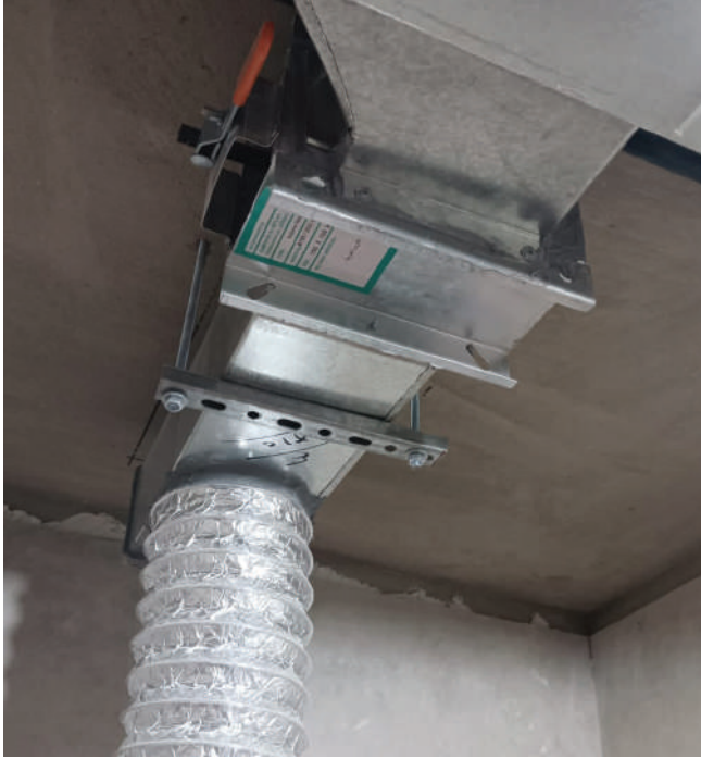
الشكل (20): طريقة نموذجية لتركيب مجرى هواء مرن.
