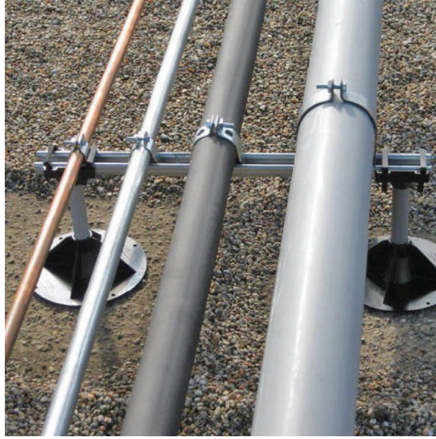
الشكل (6) حاملات أو دعائم خاصة لرفع الأنابيب عن الأرض.
