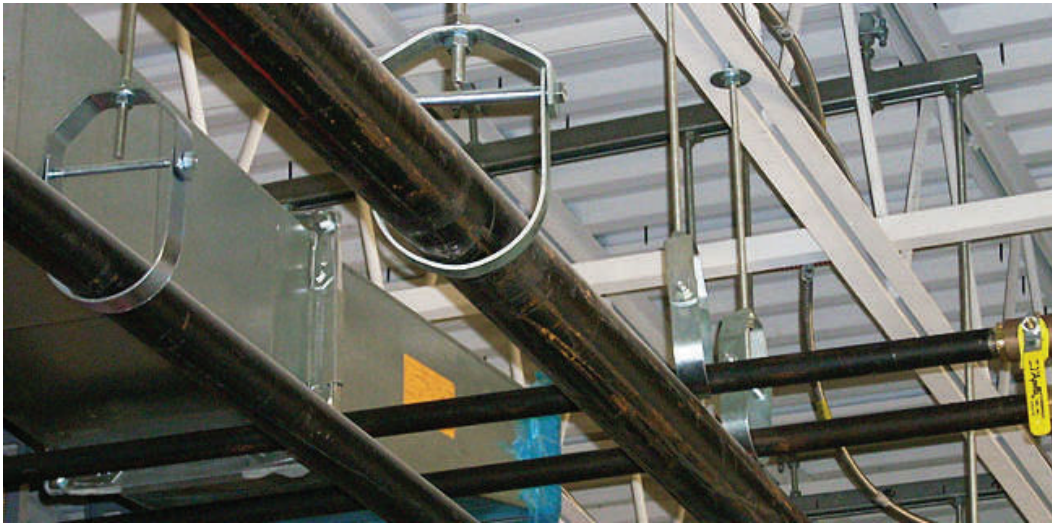
الشكل (5) تمديدات شبكة أنابيب معلقة في السقف.
