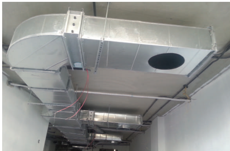
الشكل(13): تفرعات فرعية لشبكة مجاري الهواء.
