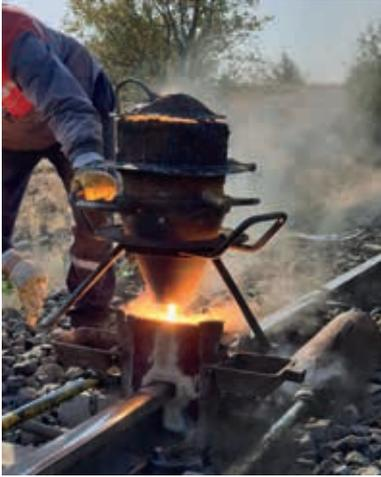
يُستخدم تفاعل الثيرمايت في لحام السكك الحديدية، إذ ينتج من هذا التفاعل كمية كبيرة من الطاقة الحرارية الكافية لصهر الحديد، ما يتيح صب الحديد المصهور مباشرة في الشقوق في مسار سكة الحديد. والثيرمايت هو تفاعل أكسيد الحديد (III)  $\text{Fe}_2\text{O}_3$  مع فلز الألمنيوم Al مُنتجاً أكسيد الألمنيوم  $\text{Al}_2\text{O}_3$  وفلز الحديد Fe. أحدد المادة التي تأكسدت والمادة التي اختزلت في المعادلة الآتية:
