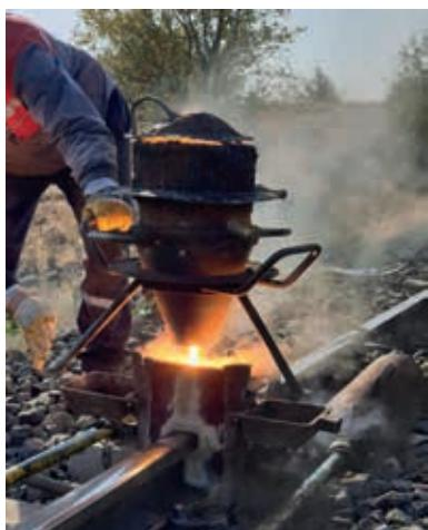
يُستخدم تفاعل الشيرمait في لحام السكك الحديدية، إذ ينتُج من هذا التفاعل كمية كبيرة من الطاقة الحرارية الكافية لصهر الحديد، ما يتبع صبَّ الحديد المصهور مباشرةً في الشقوق في مسار سكة الحديد. والشيرمait هو تفاعل أكسيد الحديد (III)  $\text{Fe}_2\text{O}_3$  مع فلز الألمنيوم Al مُنتيجاً أكسيد الألمنيوم  $\text{Al}_2\text{O}_3$  وفلز الحديد Fe. أحدهُ المادَّة التي تأكسدت والمادَّة التي اخترِّلت في المعادلة الآتية:
