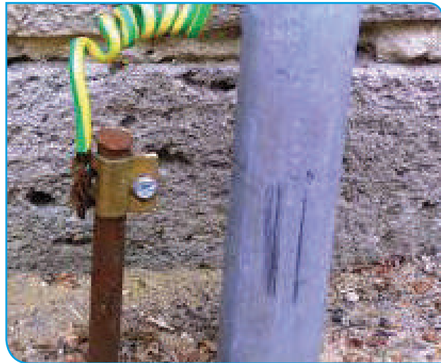
الشكل (5-110): تنفيذ حفرة التأريض.
