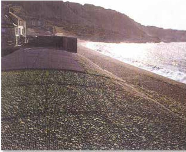
شكل (٣٣) فرشَة حجرية لحماية الشاطئ من التآكل بفعل الأمواج
