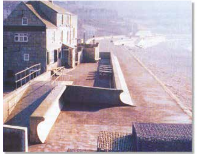
شكل (٣٢) حائط اسمنتي لحماية المباني من الأمواج البحرية
