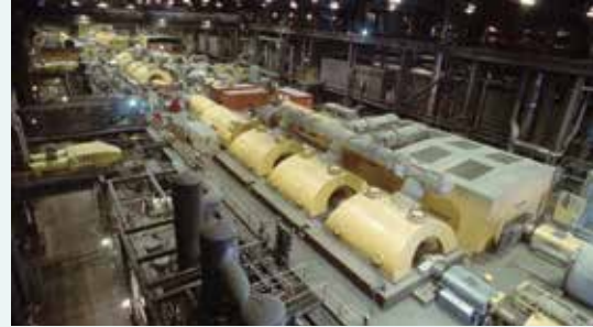
الصورة ٥-٣ تنتج مولدات محطة الطاقة هذه الكهرباء بقوة دافعة كهربائية مستحثة (25 kV).
