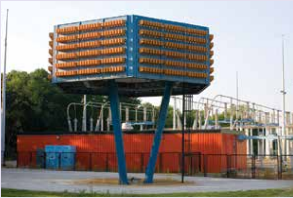
الصورة ١-٤ أحد أكبر المكثفات في العالم؛ بُني لتخزين الطاقة في مسرّع الجسيمات في مختبر فيرمي.
