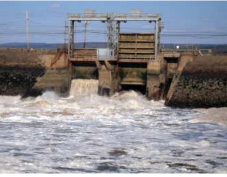
الشكل ١٨ محطة طاقة تعتمد على طاقة المد والجزر في توليد الطاقة الكهربائية.
